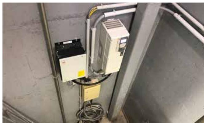
Neue Elektronik für die Regelung der Brunnenpumpe, welche sich in rund 60 Meter Tiefe befindet.
