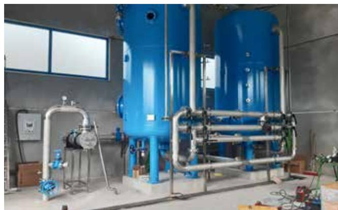
Aufbereitungsanlage mit zwei Aktivkohlefilterbehälter und einer UV-Desinfektion
