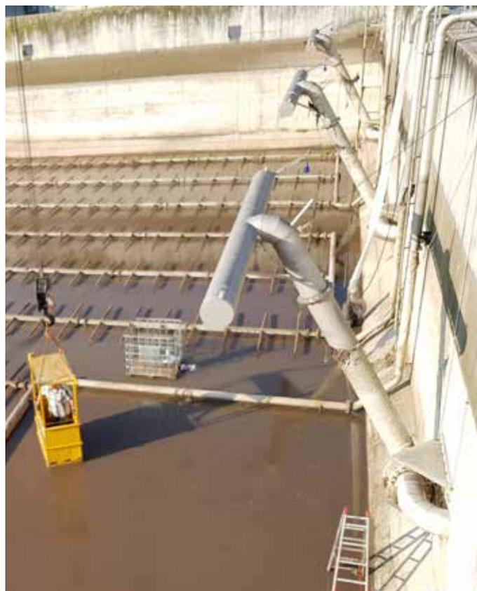
*Klärbecken zu je 45,5m x 35,5m --- Wasserstand maximal 5m – minimal 3,8m; rechts ersichtlich drei Dekanter mit Drehgelenk, welche den Abfluss des Klarwassers (gereinigtes Abwasser) nach der Absetzphase des Klärschlammes ermöglichen.*
