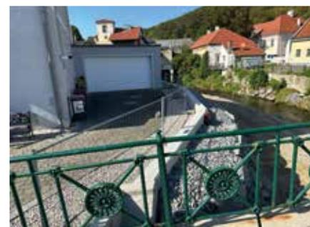
In Wöllersdorf sind derzeit die Arbeiten von der Schulgassenbrücke flussaufwärts in vollem Gange. Zuerst wurde eine Baustraße erstellt, welche mit großen Steinblöcken gesichert wurde. Diese dient allein als Bauweg und wird nach Abschluss der Arbeiten natürlich wieder zurückgebaut.
